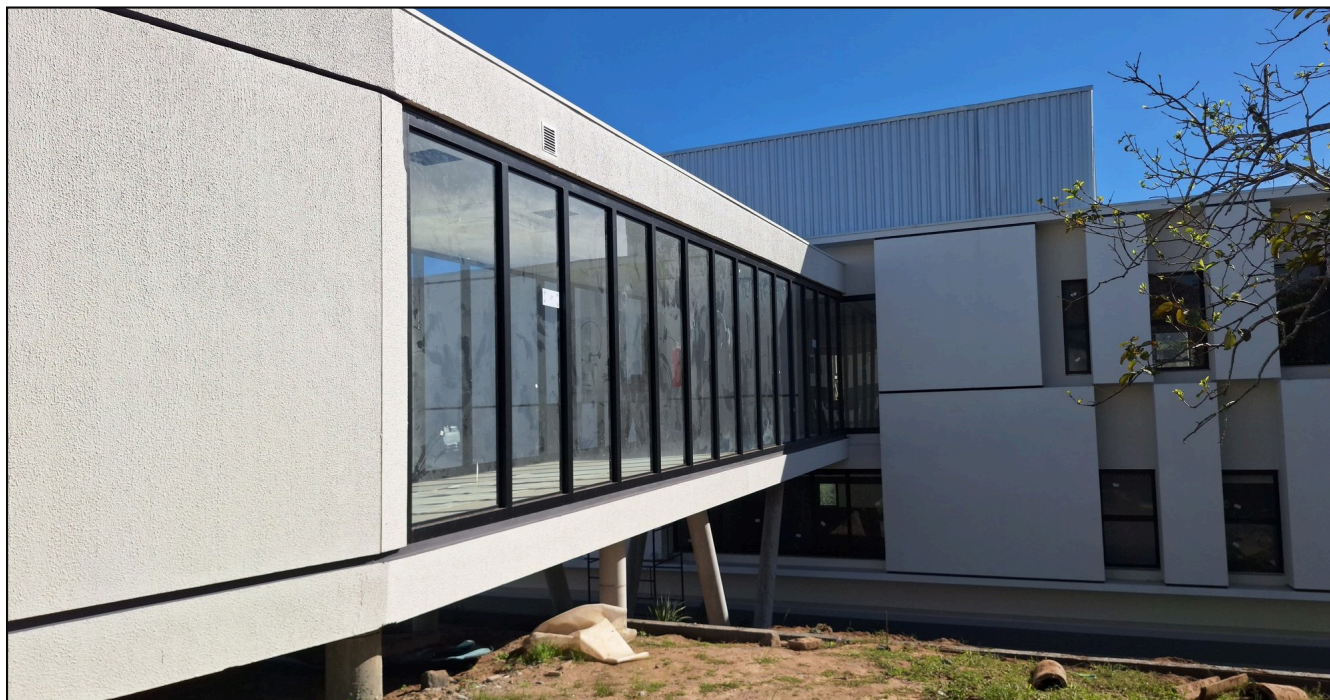
FACHADA EM VIDRO · OBRA HOSPITALAR
