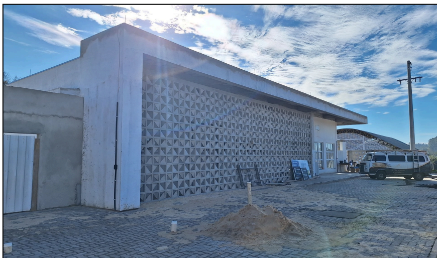
PORTAS, JANELAS E COBOGÓS EXECUTADOS CONFORME DETALHAMENTO
